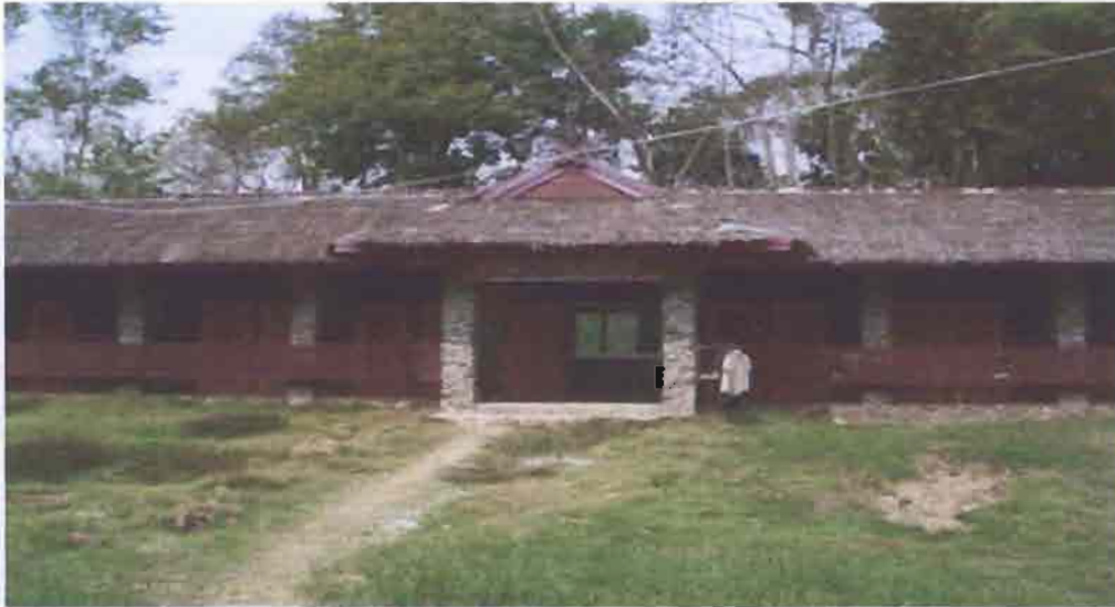
ภาพ 6 อาคารอาบน้ำแร่ของบ่อน้ำพุร้อนป่าตึง
