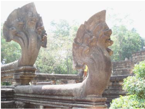
ซ่อมแซมบริเวณศรีษะนาคราช อยู่ในสภาพดี
