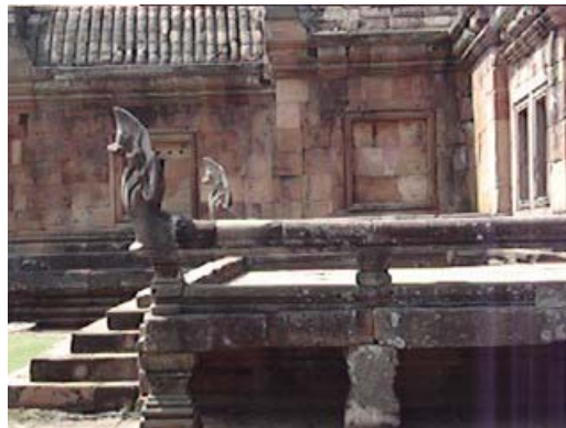
ทำความสะอาดให้อยู่ในสภาพดีเช่นเดียวกับ บริเวณราวสะพานนาคราชชั้นที่ 3
