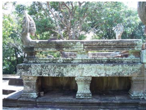
บริเวณราวสะพานนาคราชชั้นที่ 2 มีคราบฝังอยู่จากสภาพดินฟ้า อากาศ
