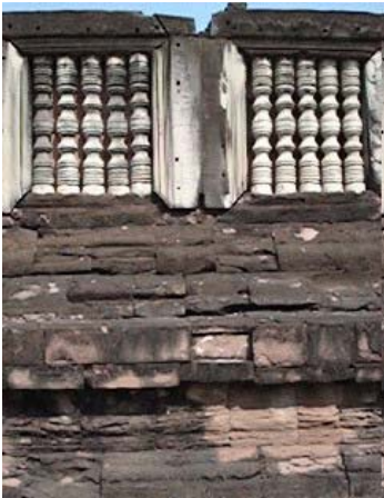
ทำความสะอาดและซ่อมแซมบริเวณฐานของ ระเบียงคตและกรอบหน้าต่างอยู่ในสภาพดี
