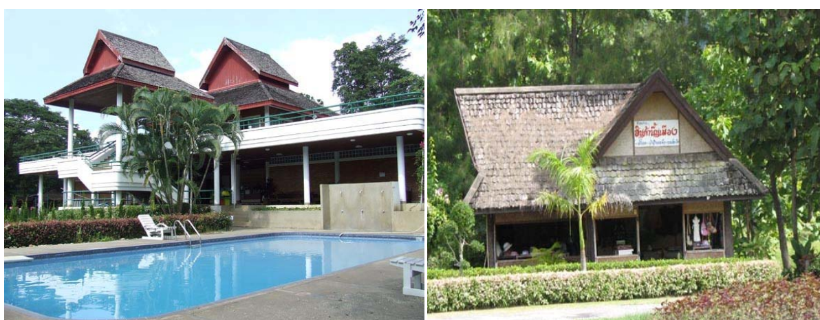
รูปที่ 4.15 รูปแบบหลังคาอาคารน้ำอาบน้ำแร่ (ซ้าย) และร้านขายของที่ระลึก (ขวา)
