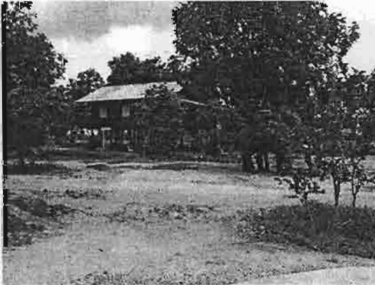
ภาพที่ 9 : พื้นที่กำลังก่อสร้างแสดงบ้านควาญช้าง
