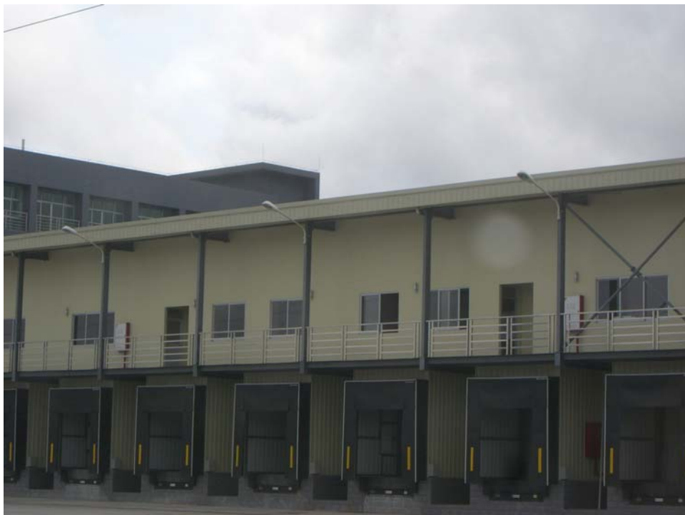
ภาพที่ 4.14 อาคารศูนย์กระจายผลไม้อินเทาซึ่งชั้น 2 เปิดให้บริการเป็นพื้นที่สำนักงาน
